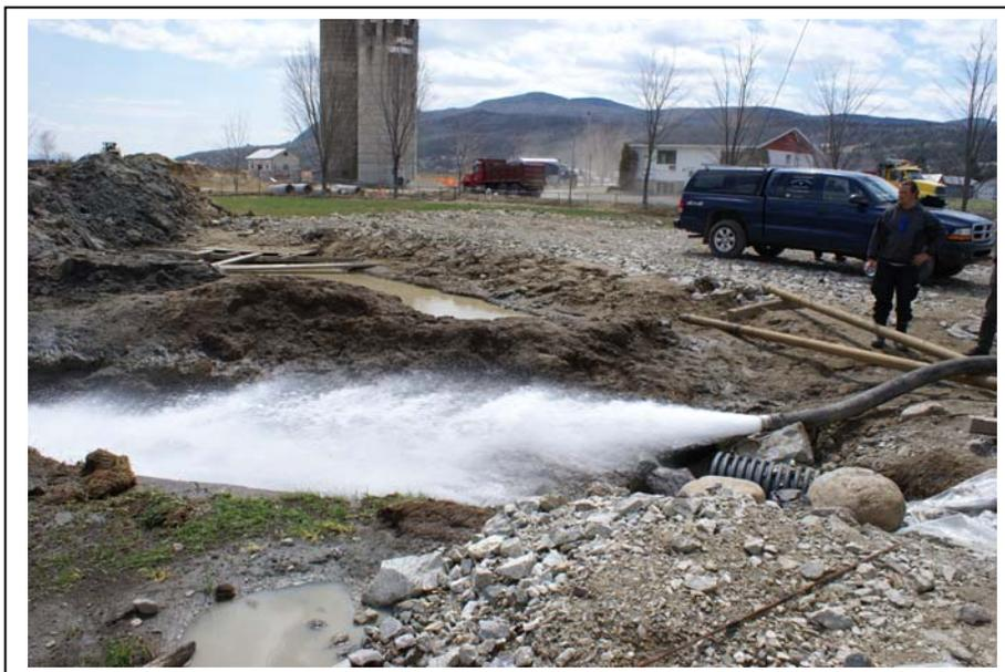
Photo 11 : Développement du puits P-2
