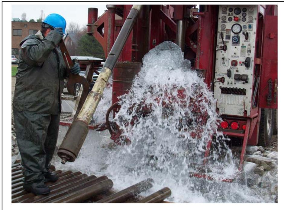
Photo 10 : Forage du puits P-2
