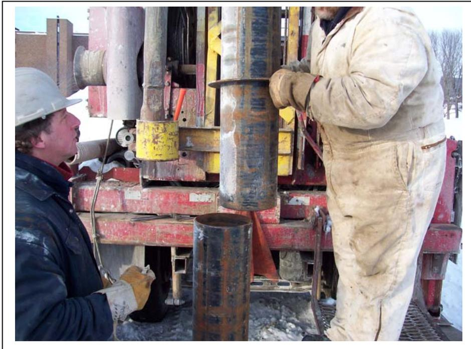
Photo 5 : Mise en place du tubage d'acier (puits P-2)
