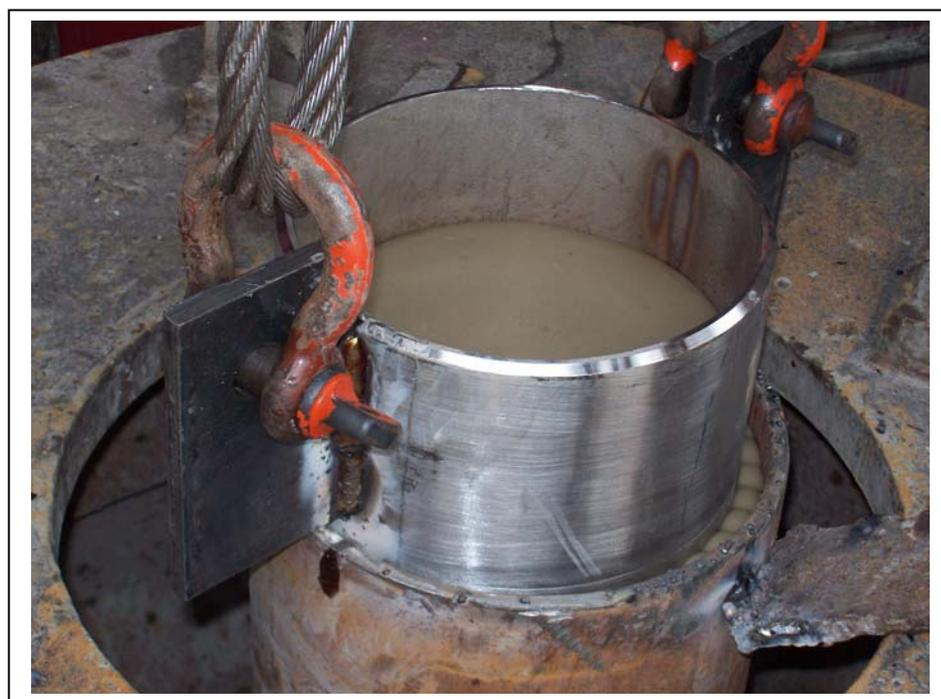
Photo 8 : Mise en place de la crépine au puits P-2
