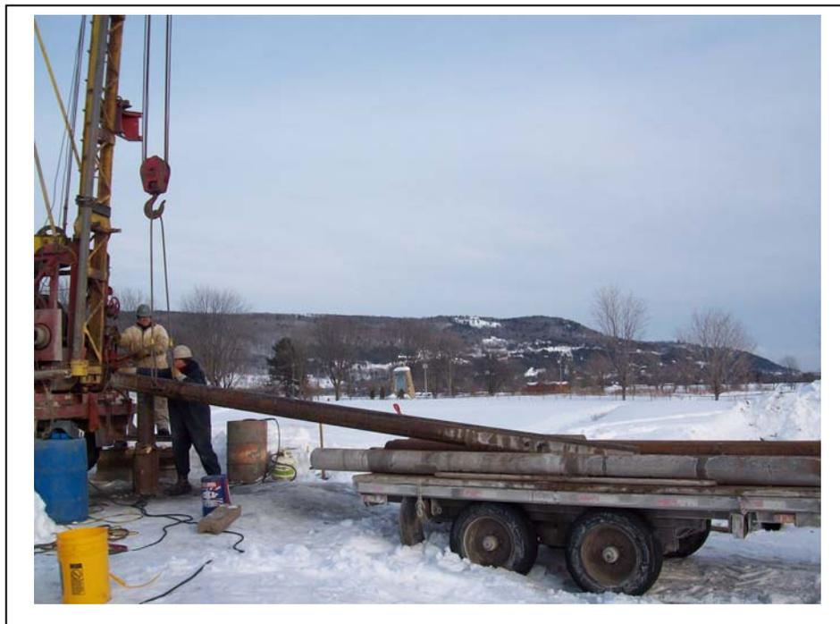
Photo 4 : Mise en place du tubage d'acier (puits P-2)
