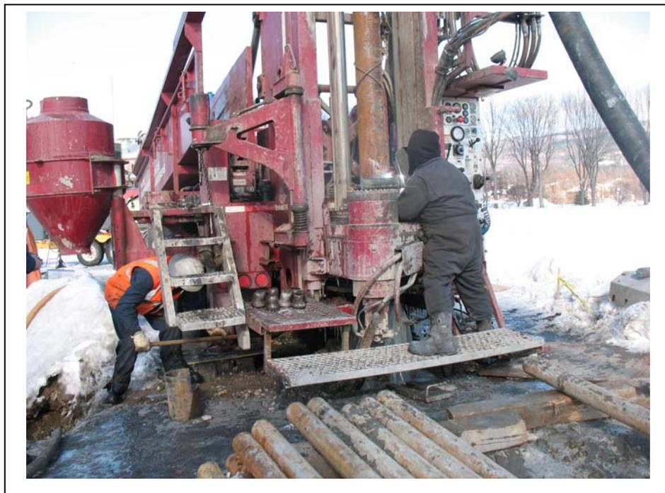
Photo 6 : Soudure du tubage d'acier (puits P-2)
