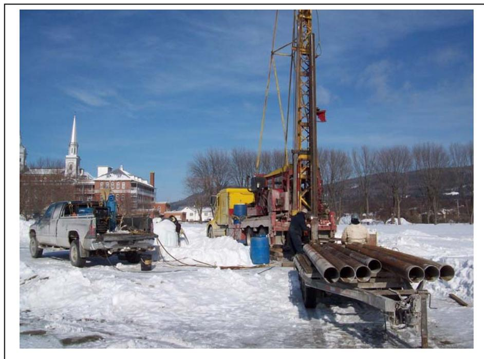
Photo 2 : Forage du puits P-2
