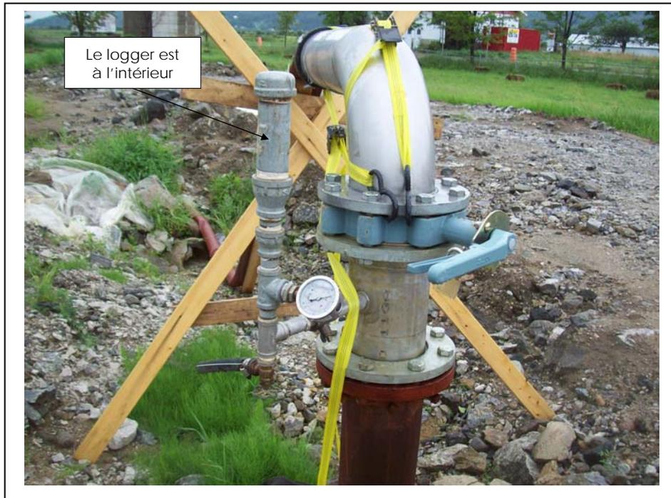
Photo 15 : Vanne et manomètre du puits P-3
