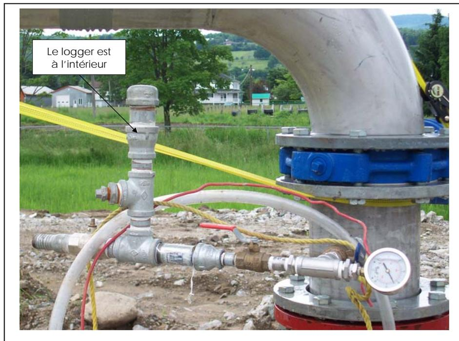
Photo 16 : Vanne et manomètre du puits P-2
