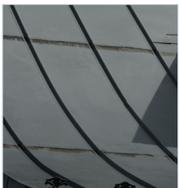
La tôle à baguette (ou profilé semblable)
